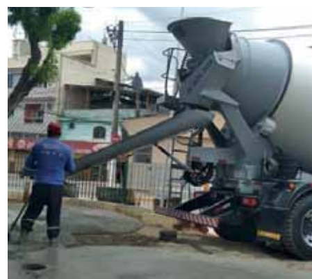
Praça Getúlio Vargas está recebendo melhorias para instalação dos equipamentos
