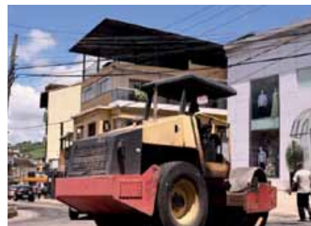
O andamento do serviço depende das condições climáticas
