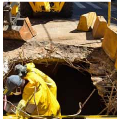
A rua Etelvina Vivacqua receberá a intervenção próximo à entrada para o Zumbi
