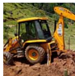
Vias foram bastante prejudicadas pela chuva, o que impedia a passagem de veículos
