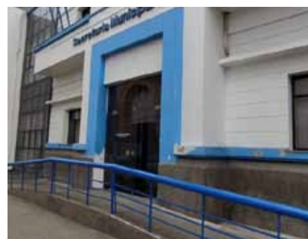
As intervenções são necessárias para melhoria do pavimento e adequação aos padrões de acessibilidade
