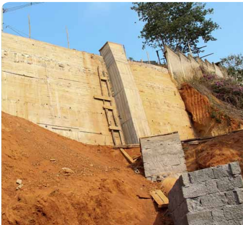
Muro de contenção de 17 metros de altura foi erguido para dar estabilidade à área
