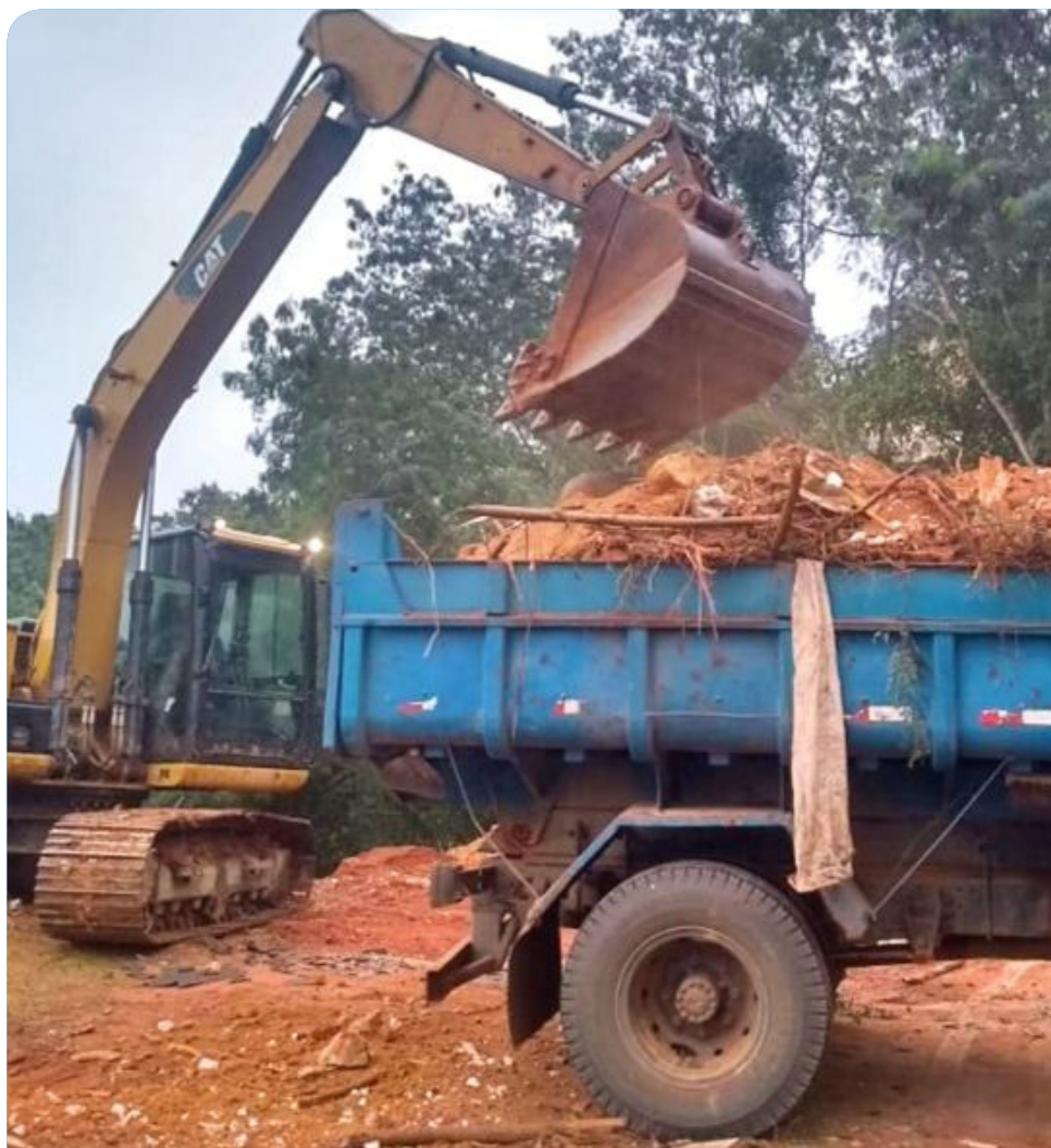
Os trabalhos se concentram na avenida Carlos Lindemberg, nos bairros Novo Parque e Rubem Braga
