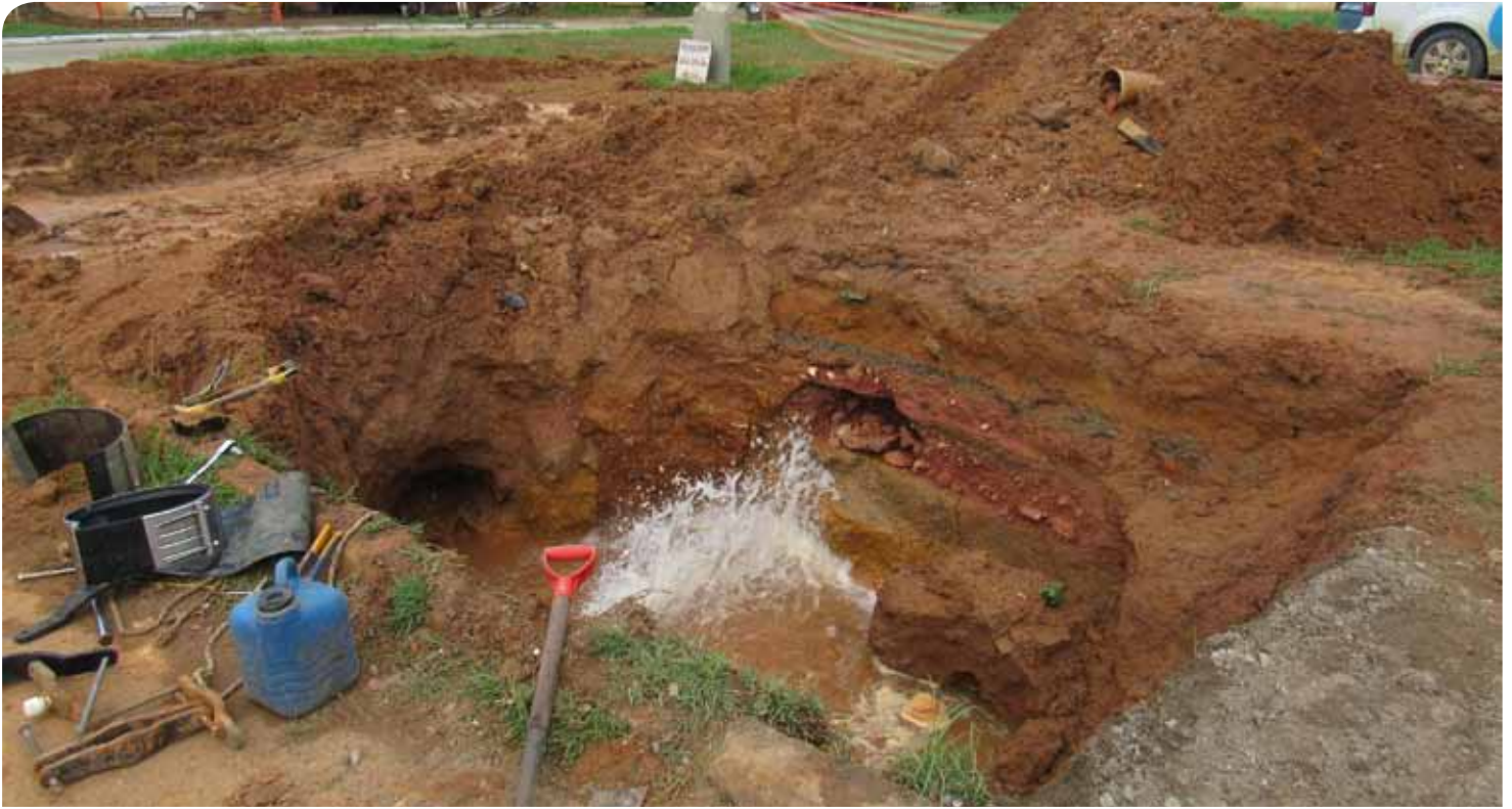
Obras para melhoria do sistema deverão ser concluídas até setembro
