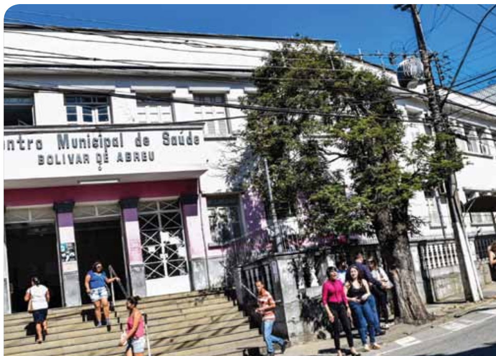
Melhorias incluem adaptação dos banheiros para pessoas com deficiência e instalação de elevador
