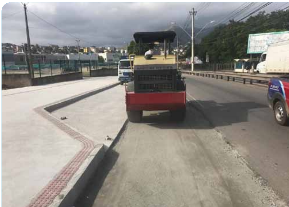
Equipes também começaram preparativos para asfaltar área incorporada à pista
