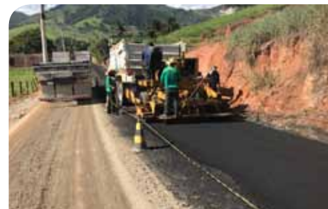
O serviço faz parte de um pacote de obras de infraestrutura e urbanização
