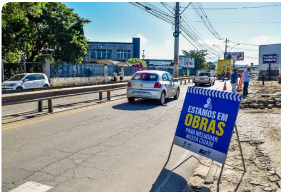
Um dos locais visitados foi o trecho da avenida Santos Neves que será ampliado
