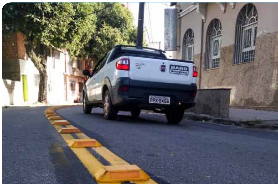
Na rua Moreira, foram instalados 60 tachões refletivos, para redução de velocidade
