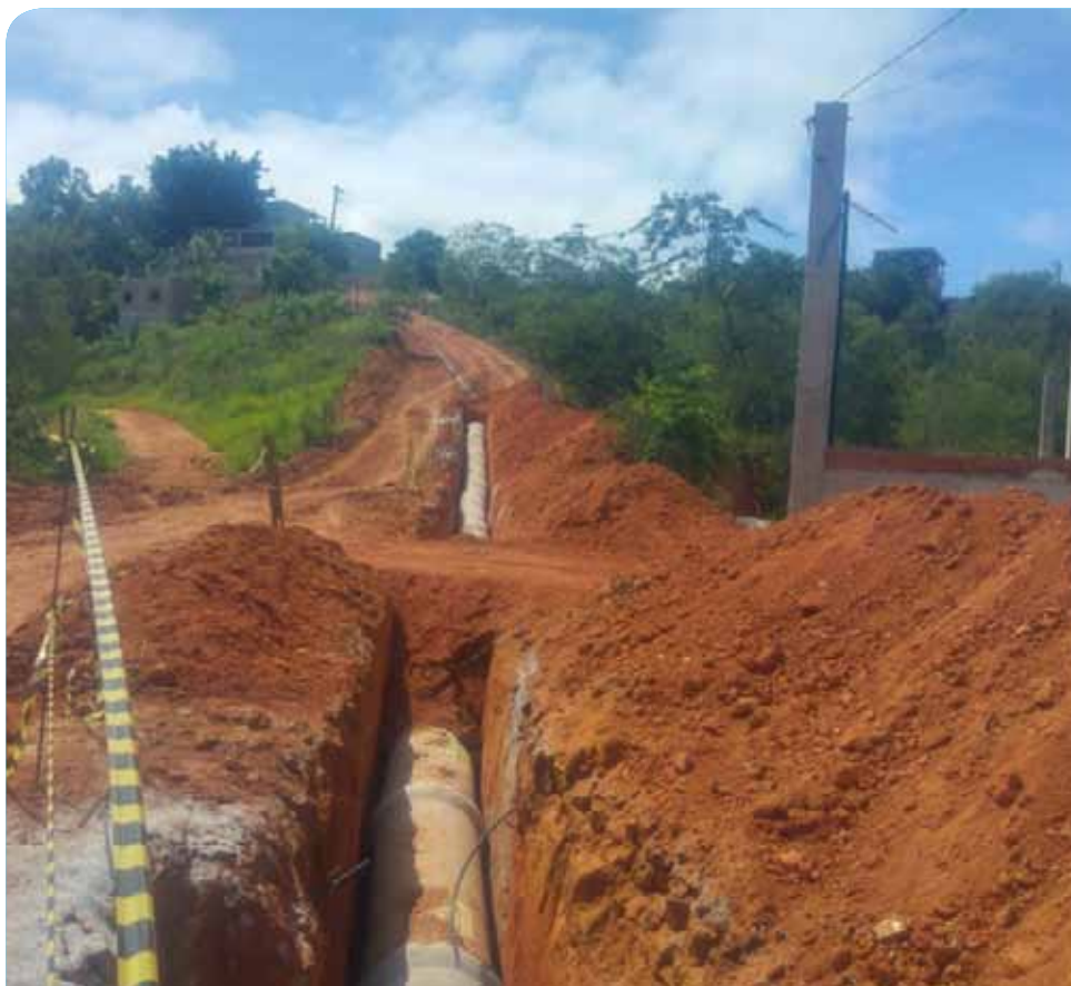
O trabalho mais adiantado é o de implantação de rede de drenagem
