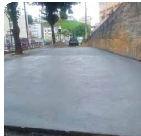
O espaço já conta com novo piso de concreto na área externa
