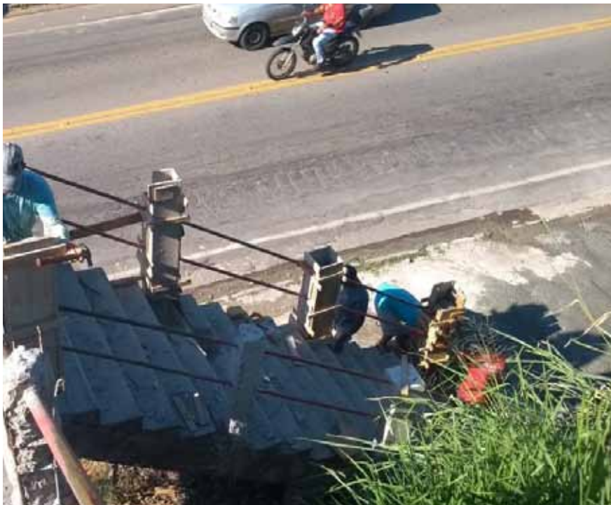
Obra na escadaria da Aristides Campos entra em sua última etapa
