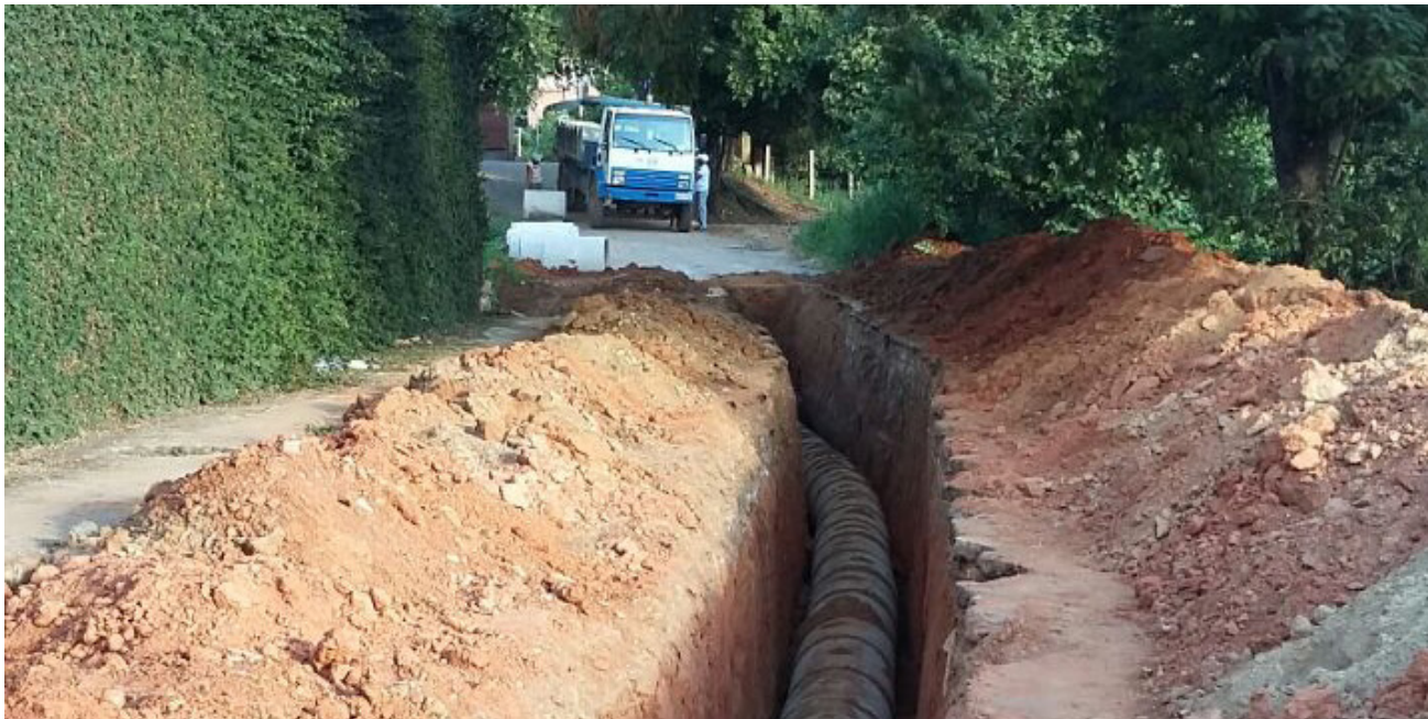
Geralmente feito via obra direta, pela grande extensão, o serviço no bairro conta com recursos próprios
