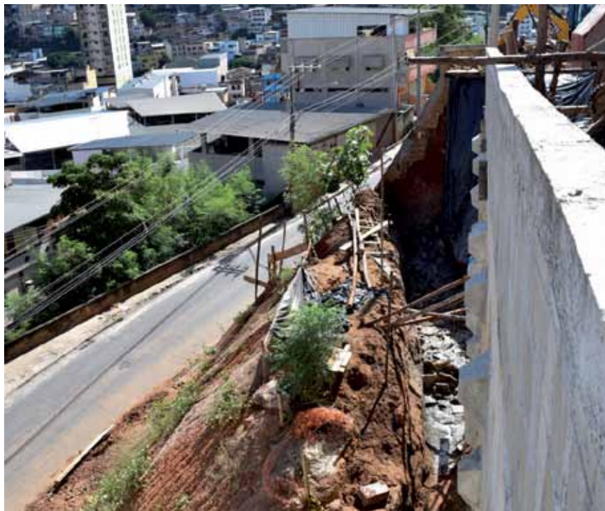
Etapa segue até meados de maio no trecho, no bairro Recanto
